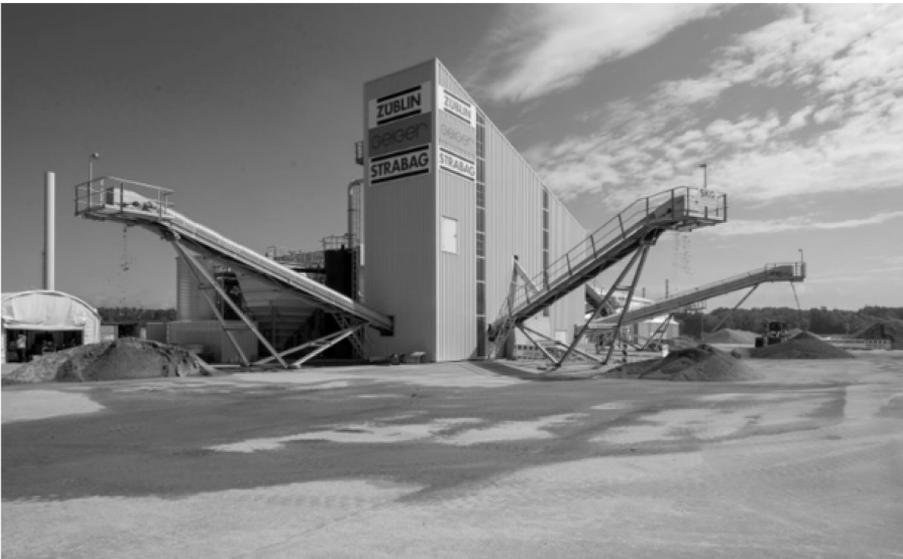
Abb. 5: Bodenwaschanlage mit Aufbereitungsanlage für PFAS-haltiges Prozesswasser, Durchsatzleistung 1.200 t/d.
