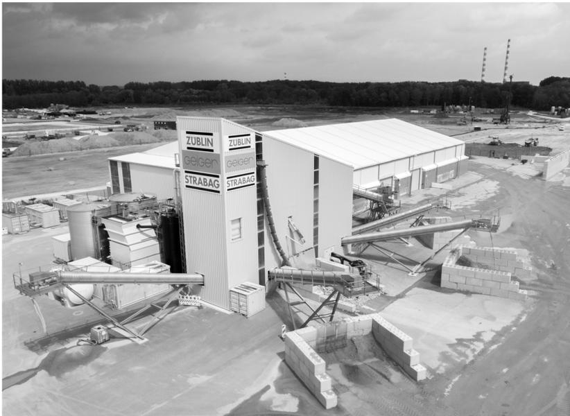
Abb. 3: Bodenwaschanlage mit Schlammbehandlung auf dem zentralen Aufbereitungsplatz (ZAP).
