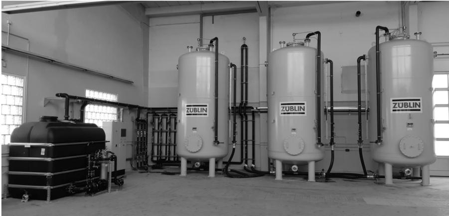
Abb. 2: Reinigungsanlage für PFAS-haltiges Grundwasser, Durchflussrate 30 m<sup>3</sup>/h.
