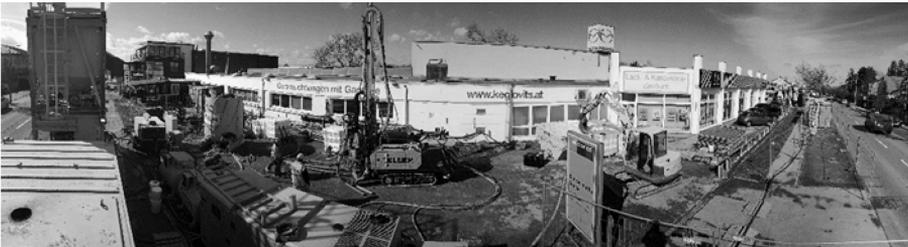
Abb. 2: Panoramaaufnahme der Baustelle (am linken Bildrand sind die beiden Hochdruckpumpen und der Horizontalsilo zu sehen).
