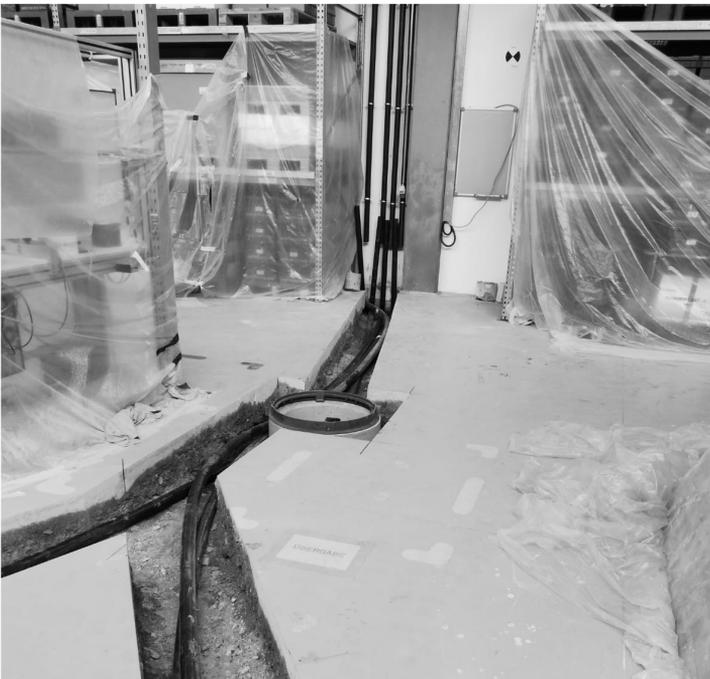
Abb. 2: Leitungsführung für BLA, Ableitung über Hallendecke.
