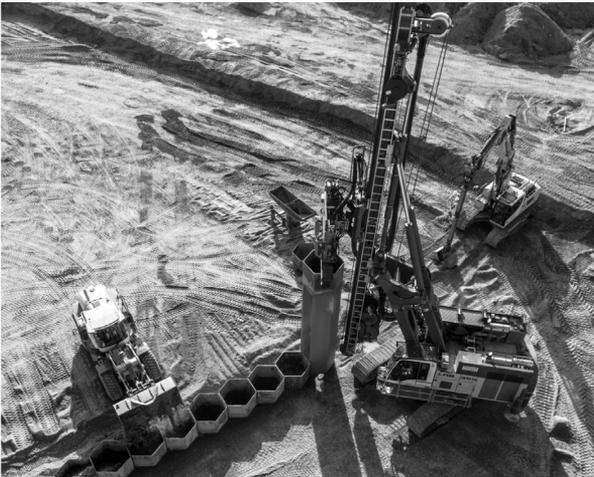
Abb. 2: Wabenkolonne bestehend aus Mäklern geführtem Vibrationsgerät, Kettenbagger mit Greiferverlängerung, Radlader zur Wiederverfüllung.
