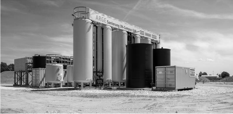
Abb. 1: Geländeabstromsicherungsanlage mit einer Leistung von bis zu 210 m<sup>3</sup>/h.
