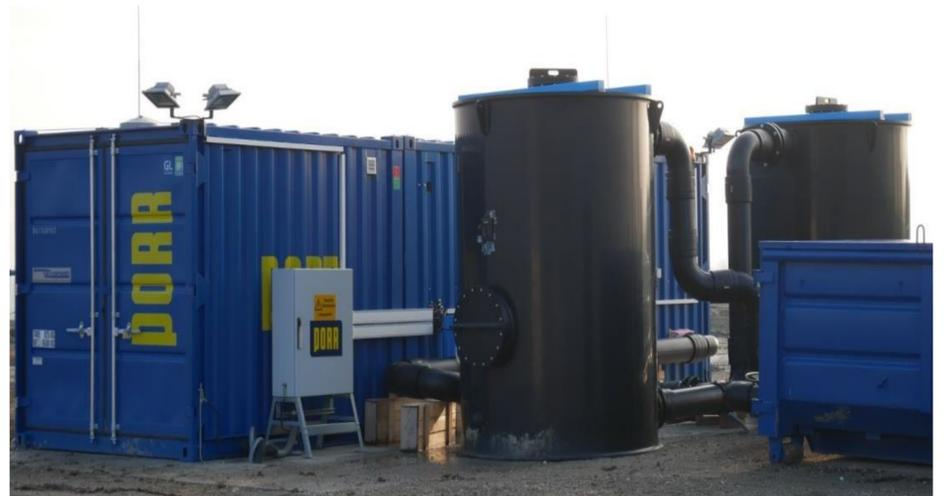
Abb. 6: Containerausführung der Absauganlage (v.l.n.r.): Steuerungs- und Maschinencontainer, Aktivkohlefilter (schwarz) und Biofiltern (niedriger blauer Abrollcontainer)
