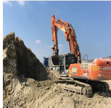
Abb. 4: Abtransport von Schlitzwandmaterial
