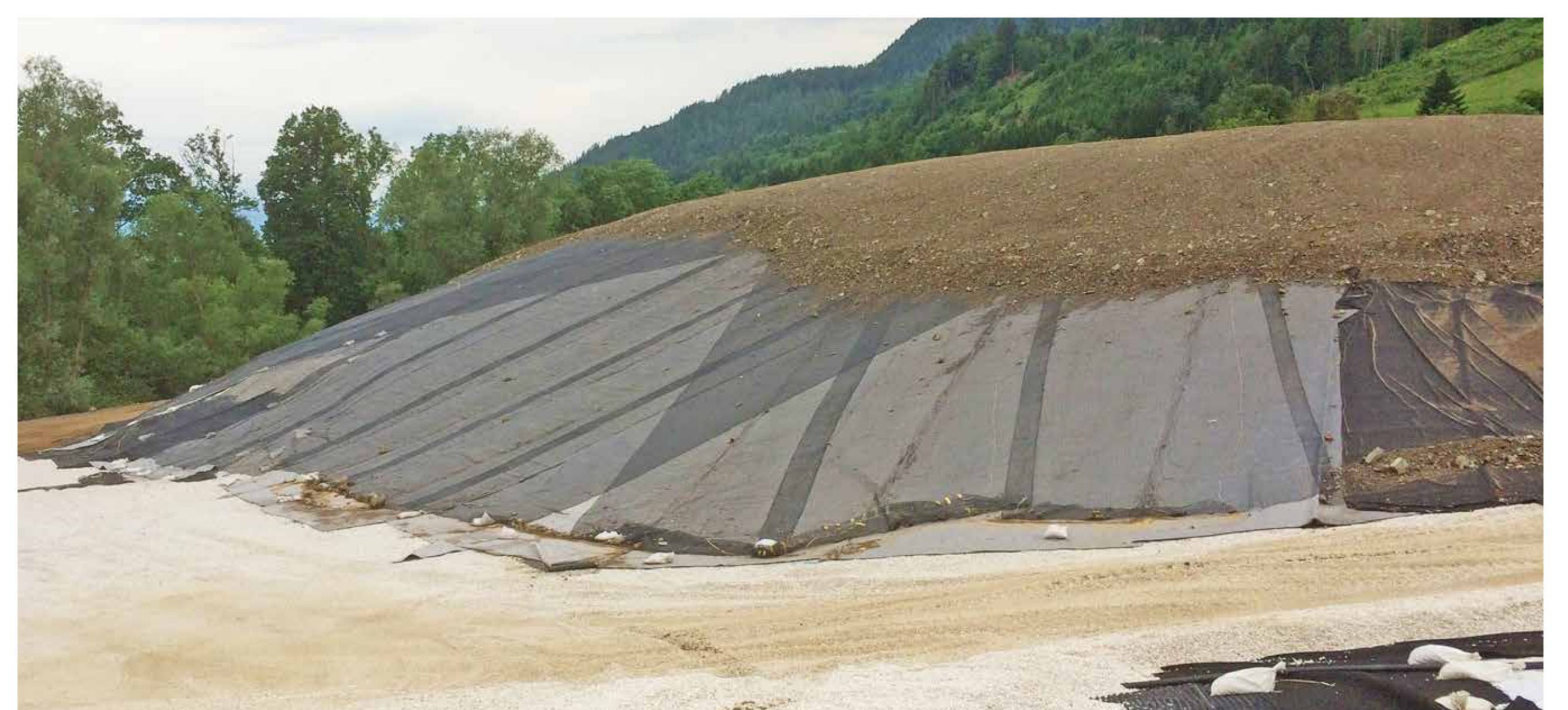
Überdeckung mit Abdeckboden im Vor - Kopf - Verfahren
