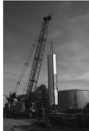
Abb. 2 & 3: Herstellung Dichtwand und Einbau Filterelemente
