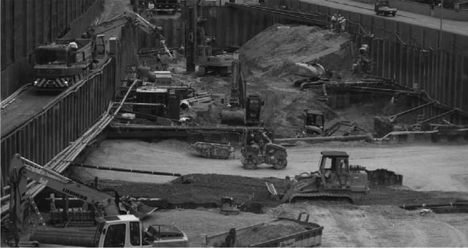
Abb. 3: Von unten: Das erste Kompartiment ist verfüllt, das zweite wird verfüllt und verdichtet, im dritten findet Aushub statt, in nächsten wird die Wasserhaltung vorbereitet
