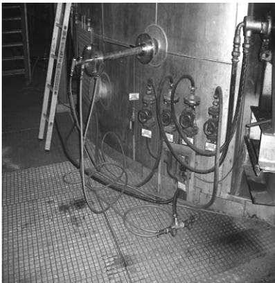
Abb. 8: Eine von drei Zweistoffdüsenlanzen zur Eindüsung verdünnter NaBr-Lösung ins Freeboard dicht oberhalb der Bettoberfläche
