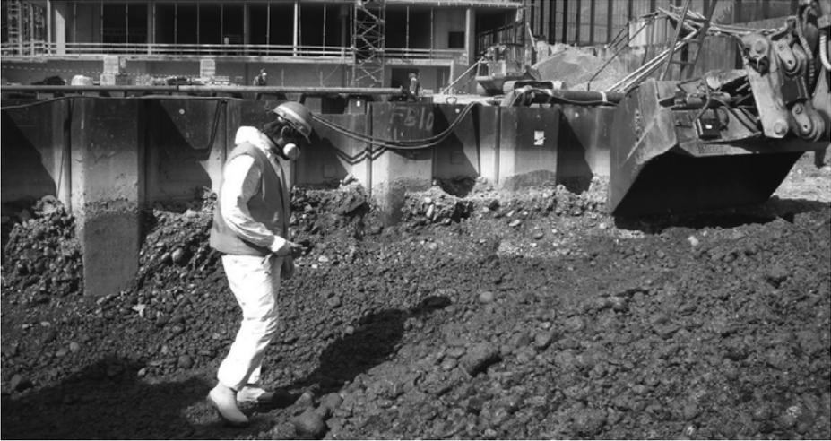
Abb. 4: Teilweise waren die Ausgasungserscheinungen des mindesten 50 Jahre alten Verunreinigungs-herdes noch so groß, dass mit Atemschutzmasken triagiert werden musste
