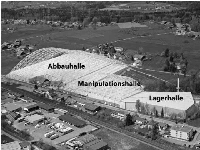
Abb. 1: Dichte Hallen für den Deponierückbau
