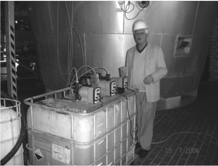
Abb. 7: Behälter für verdünnte NaBr-Lösung und 3 Förderpumpen für die 3 Lanzen
