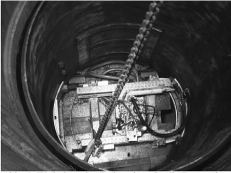
Abb. 5: Einheben der Bohranlage in die Baugrube
