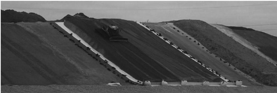
Abb. 1: Befahrung einer 1 : n = 1 : 2 geneigten Oberflächenabdichtung
