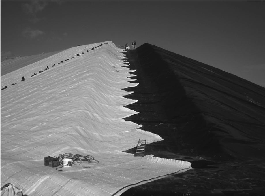
Abb. 3: Ausbildung eines Flankengrabens zur Verankerung des Geogitters im Kurvenbereich
