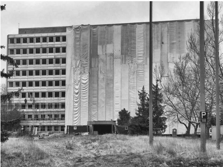
Abb. 1: Ansicht Südfassade mit Einhausung.
