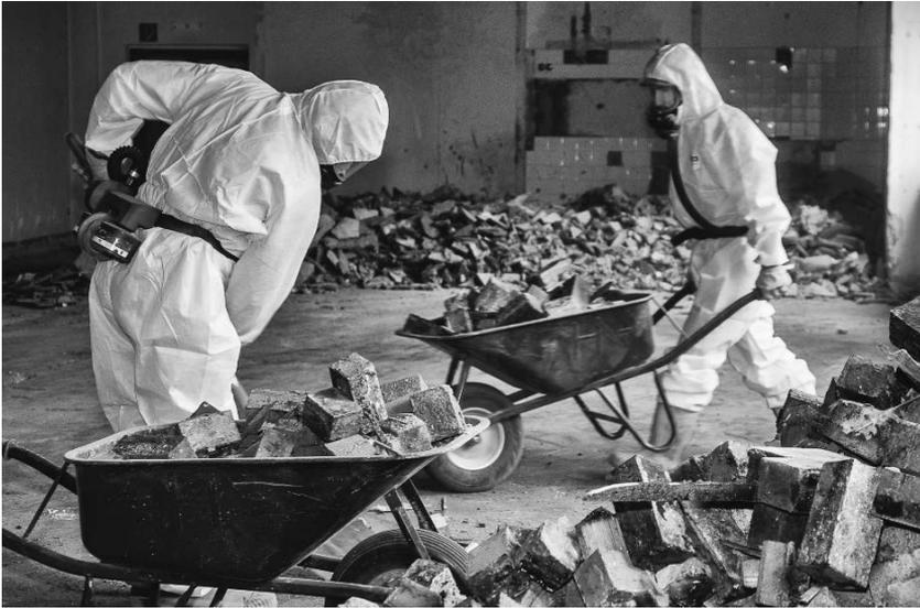
Abb. 3: Ausbau des PAK – haltigen Holzstöckelbodens.
