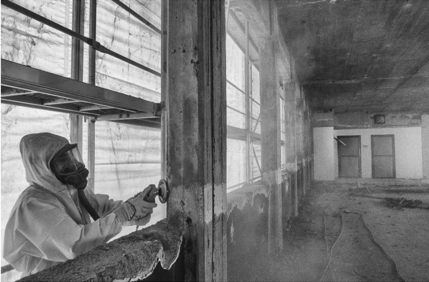
Abb. 2: Arbeiten innerhalb der Zone – Reinigung der Betonflächen.
