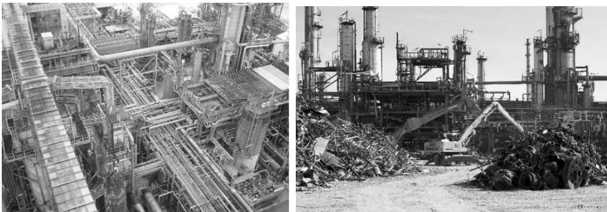
Abb. 2: Rückzubauende Rohrleitungstrassen und Anlagendemontage.
