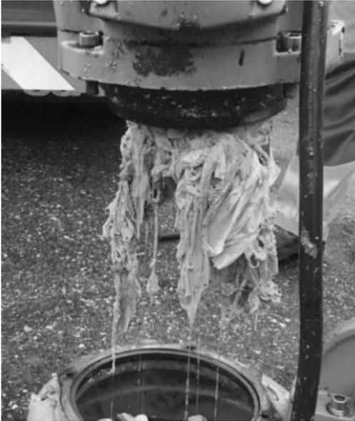
Abb. 6: Zerlegte Pumpe mit Verzopfung aus FT aus einer Pumpstation in Kapfenberg.
