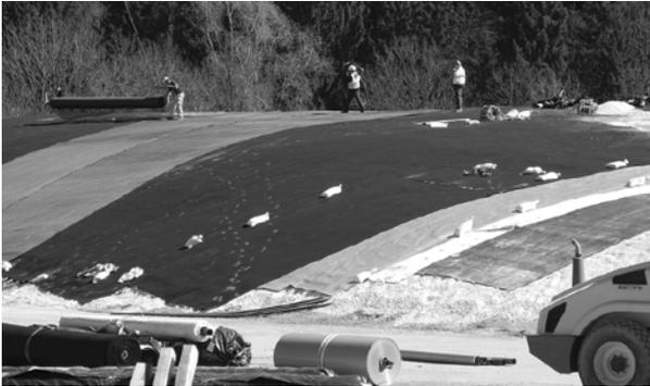
Abb. 2: Installation der Oberflächenabdichtung.
