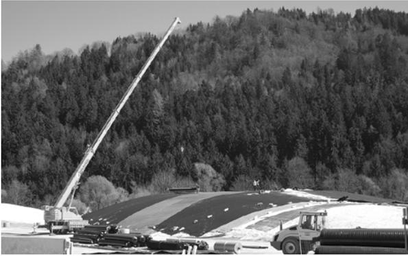
Abb. 5: Mobilkraneinsatz für die Verlegung der Geokunststoffe.
