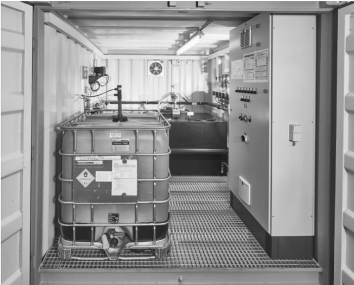
Abb. 5: Dosierstation für Permanganat.
