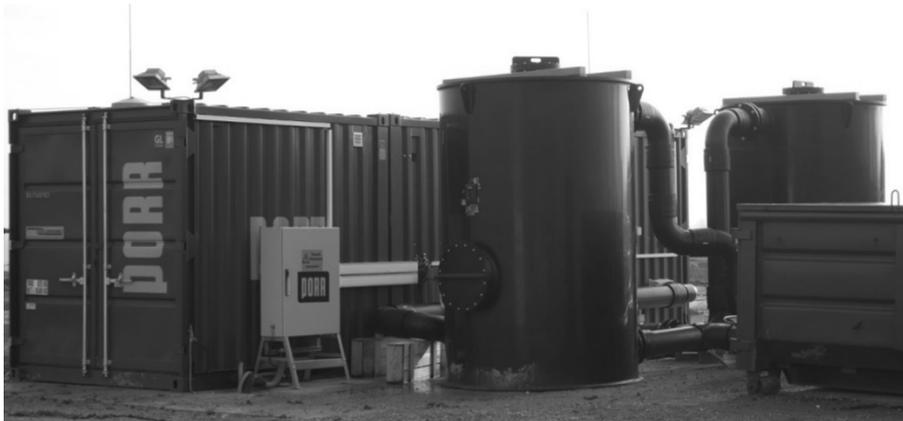
Abb. 4: Containerausführung der Absauganlage (v.l.n.r.): Steuerungs- und Maschinencontainer, Aktivkohlefilter(schwarz) und Biofiltern (niedriger blauer Abrollcontainer).
