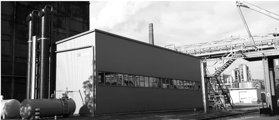
Abb. 1: Außenansicht der Anlage zwei 12 m hohen Strippkolonnen und Schlammbehälter.
